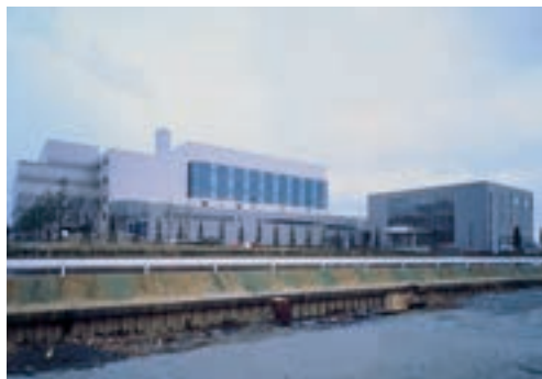
基幹改良工事を受注した新潟市亀田清掃センター(外観)
